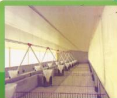
Creche com Automação
